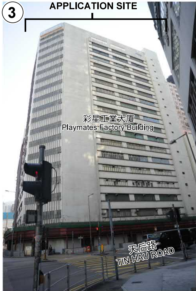
攝於2019年12月12日的實地照片 SITE PHOTO TAKEN ON 12.12.2019
