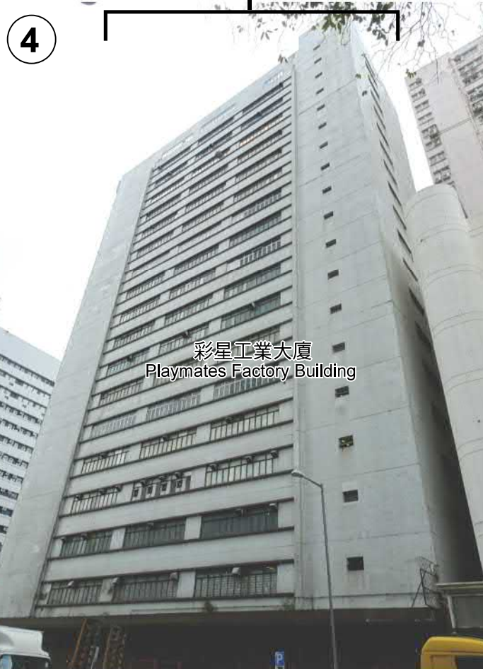
攝於2019年10月10日的實地照片 SITE PHOTO TAKEN ON 10.10.2019
