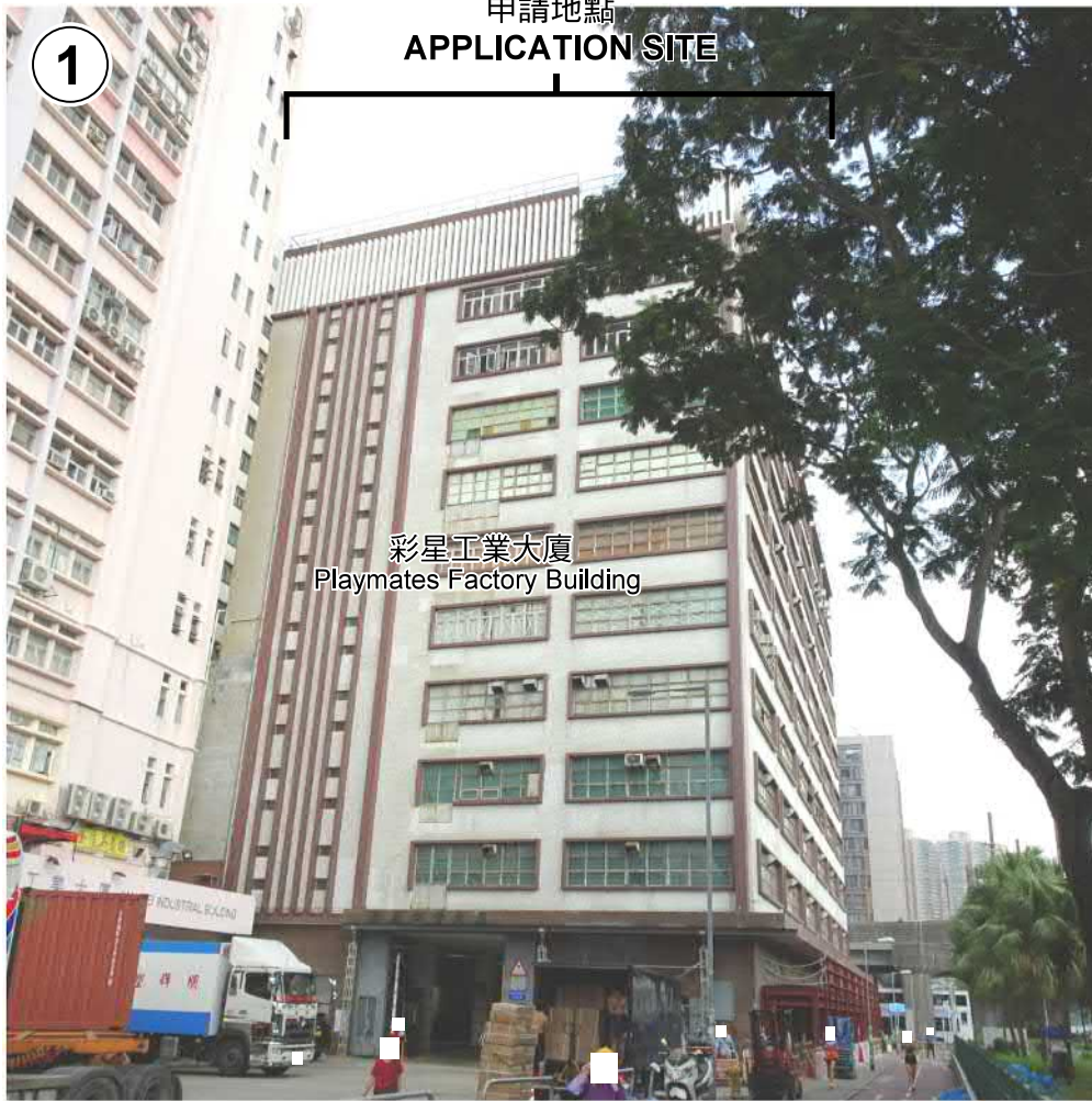
攝於2019年10月10日的實地照片 SITE PHOTO TAKEN ON 10.10.2019
